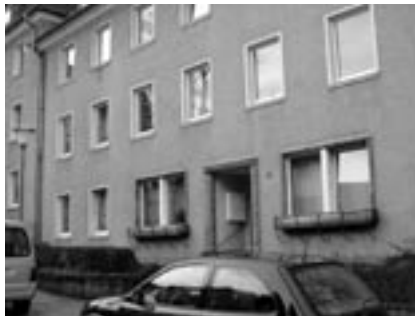
Dreyener Straße 2a (links) und Jüngststraße 10 beide 1951 erbaut.
