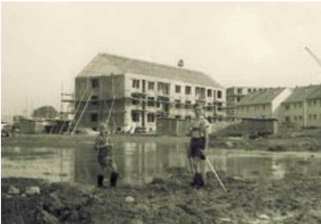
„Spielplatz“ Baustelle, Hägerweg, ca. 1959.
