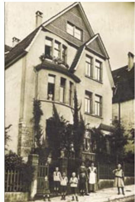
Umlandstraße 11, Aufnahme vermutlich 1918, im Vordergrund die Kinder Heidbreder und Schmieke. Im 1. Obergeschoss schaut Frau Lohmann aus dem Fenster.
