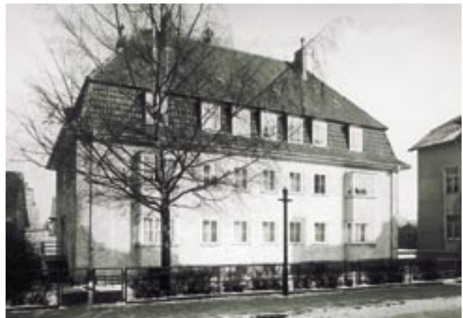
1938 entstand auch das Haus Lemgoer Straße 1/3 mit 6 Wohnungen.
